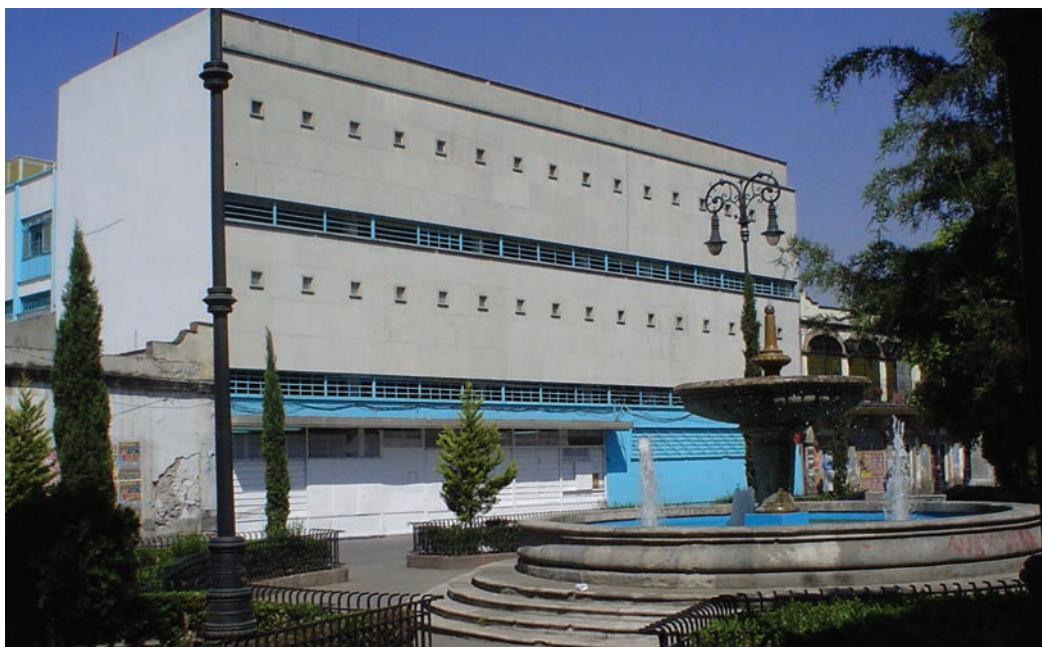
Fachada del edificio principal.
