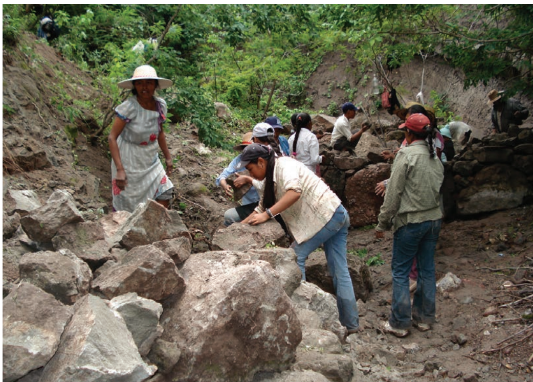
Las mujeres de la comunidad tienen una participación destacada en el proyecto, colaboran con su mano de obra en la construcción de las presas y otras obras de conservación de agua y suelo.
